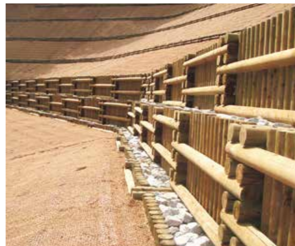
施工例／土留工
