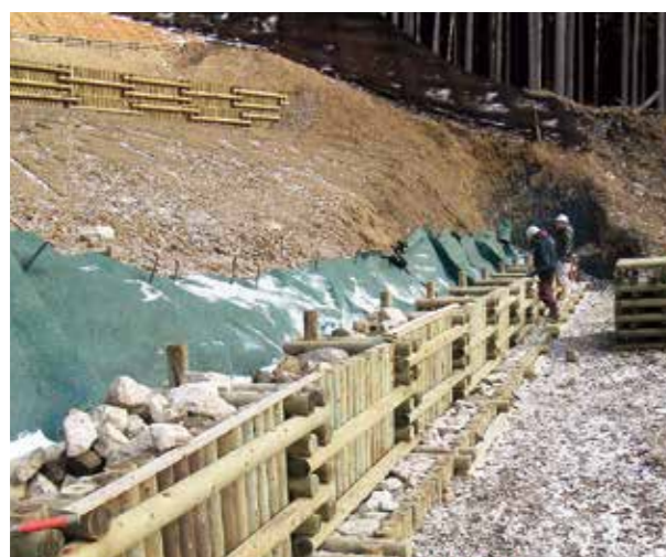
施工例／栗石敷詰
