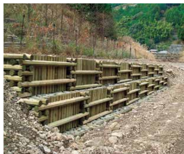
施工例／護岸工
