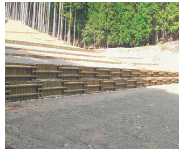
施工例／土留工
