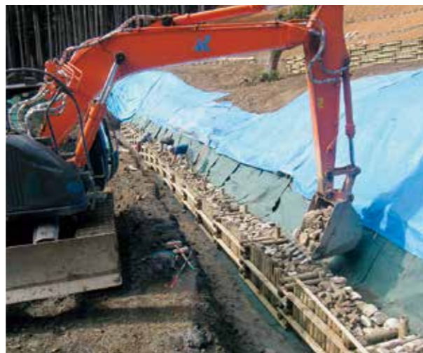
施工例／栗石投入
