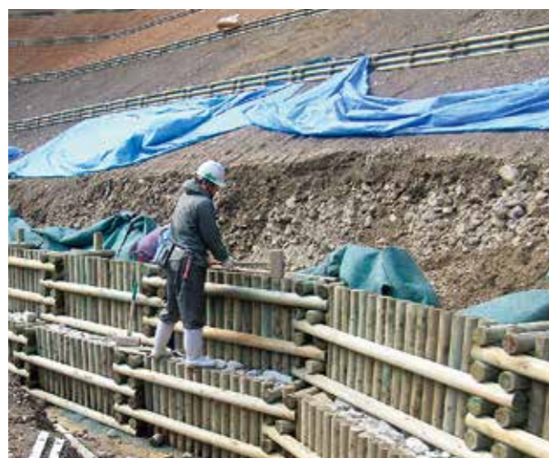
施工例／支柱打込み
