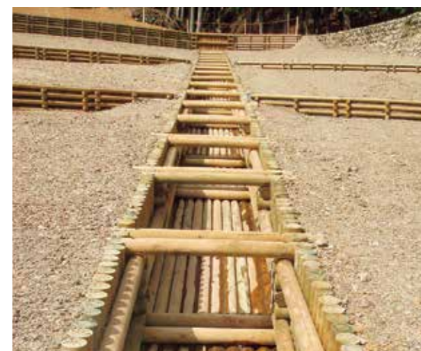
施工例／水路工
