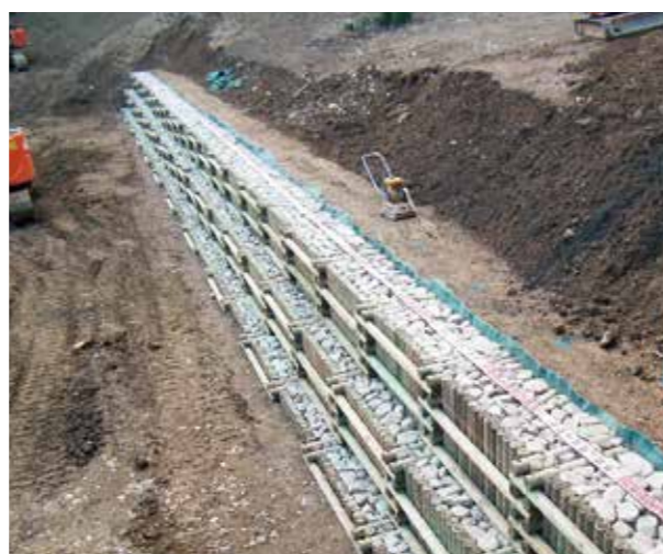
施工例／栗石完了
