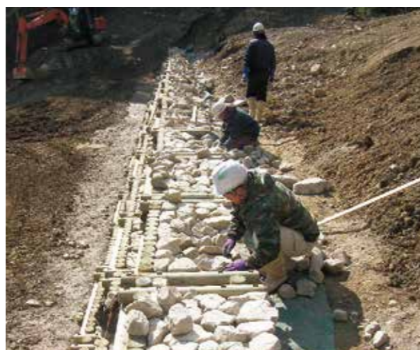
施工例／栗石敷詰
