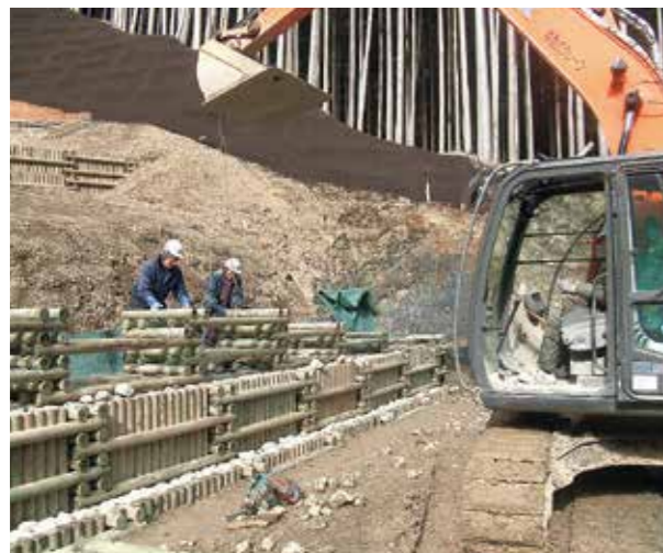
施工例／二重井桁枠・組立
