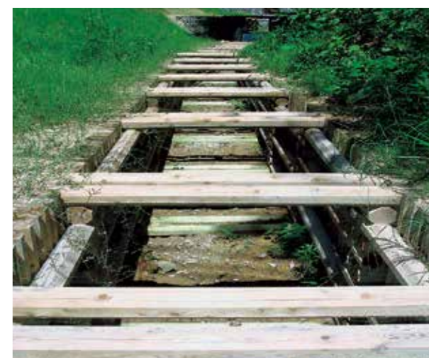
施工例／水路工(底施工なし)
