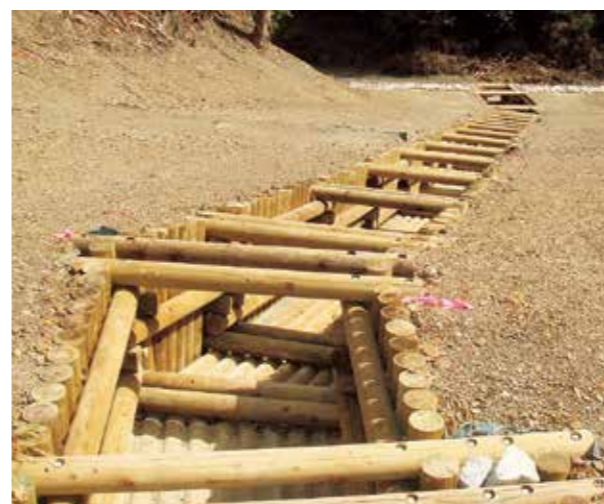
施工例／水路工
